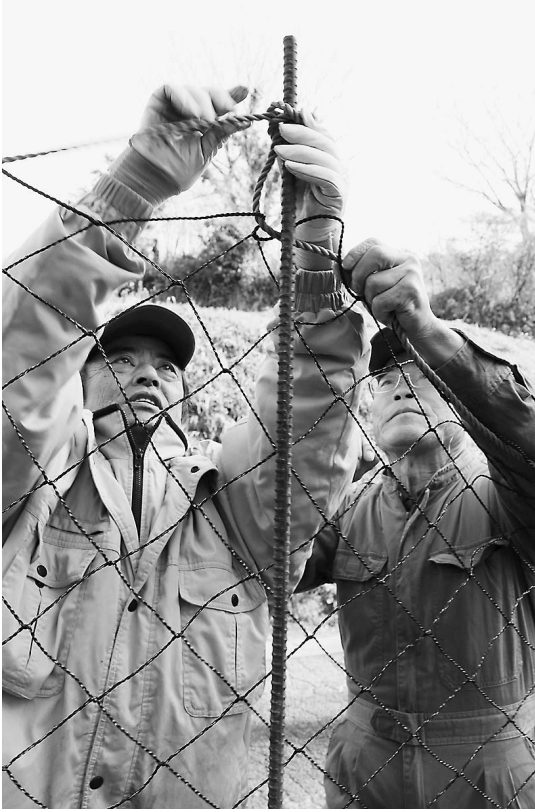
協力してネットを設置
