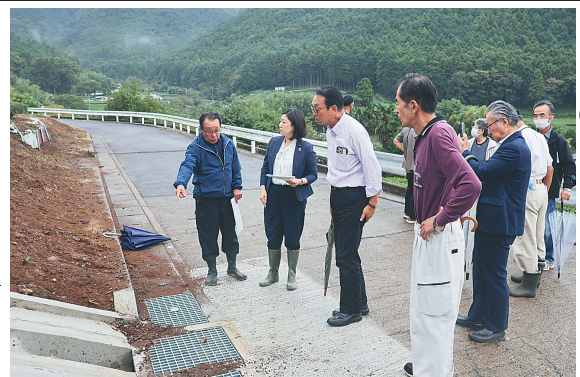
地下排水管の設置について説明する高梨さん
