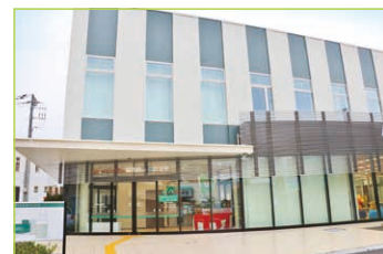
④本町支所
