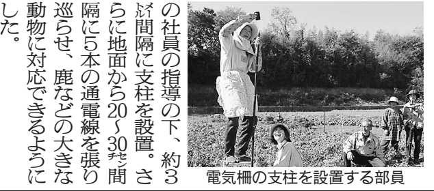
電気柵の支柱を設置する部員
